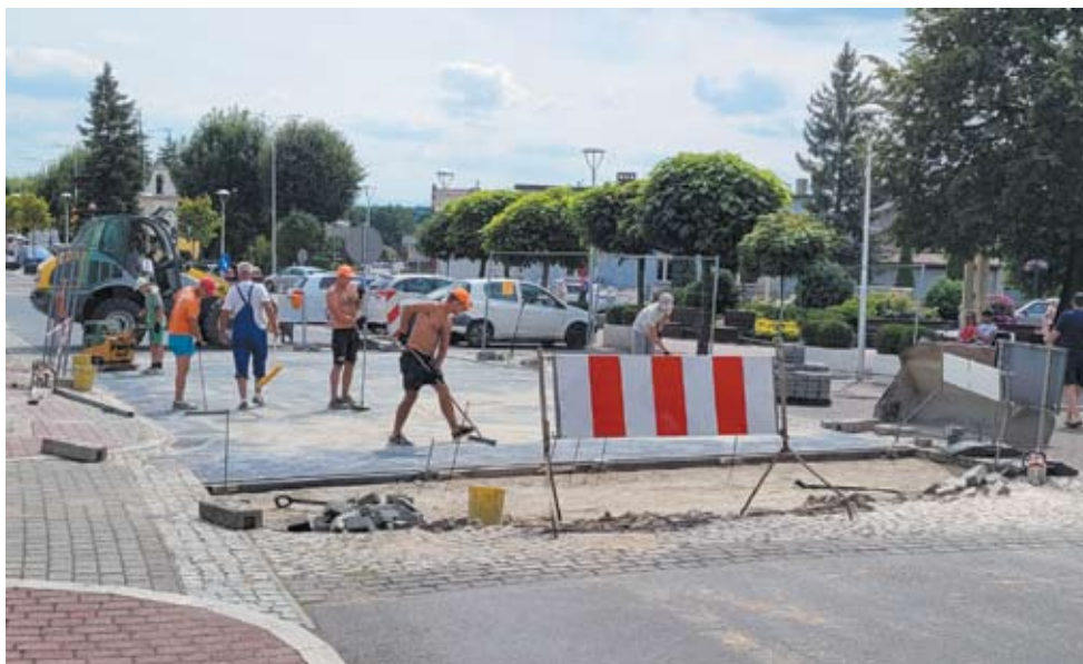
Prace na ul. Wyzwolenia przy wymianie nawierzchni
