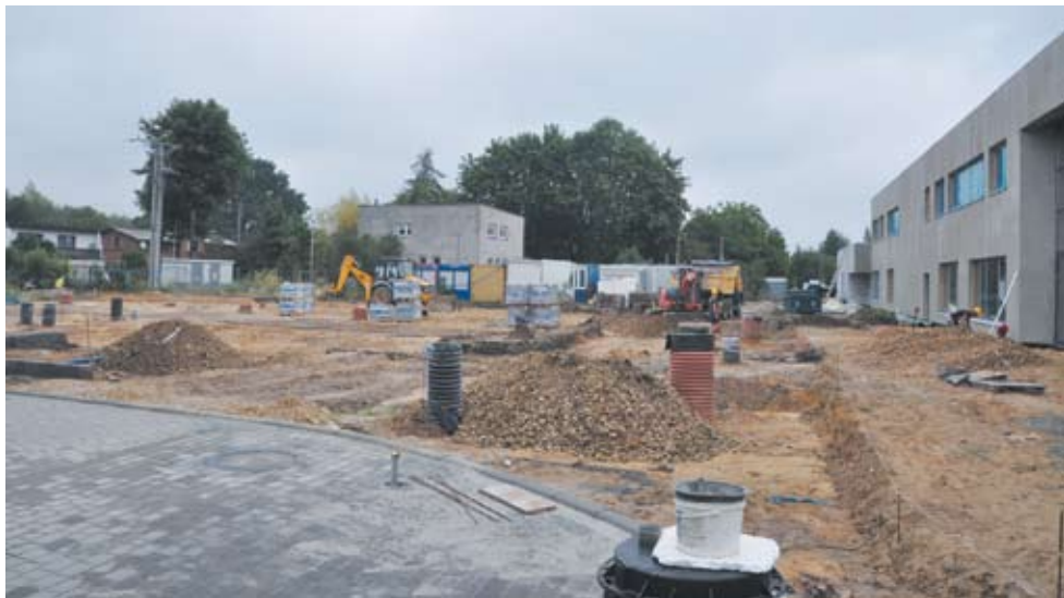
Powstaje parking przed wejściem do obu budynków.
