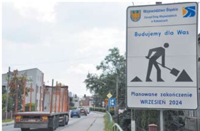
Pojawiły się już tablice informujące o inwestycji.
