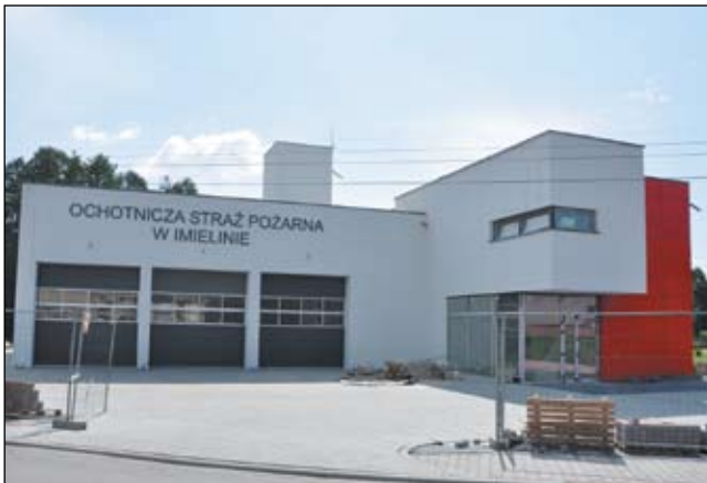
Wykonawca opóźnia oddanie do użytku strażnicy OSP.
