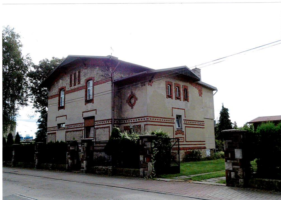
Widok od strony północno-zachodniej
